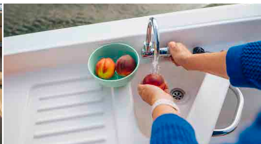
Módulo de entretenimiento con fregadero de agua dulce, nevera y espacio de estiba
