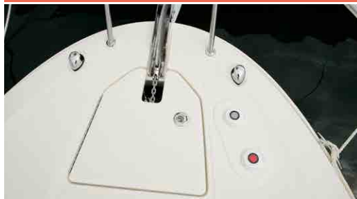
Molinete eléctrico de proa
